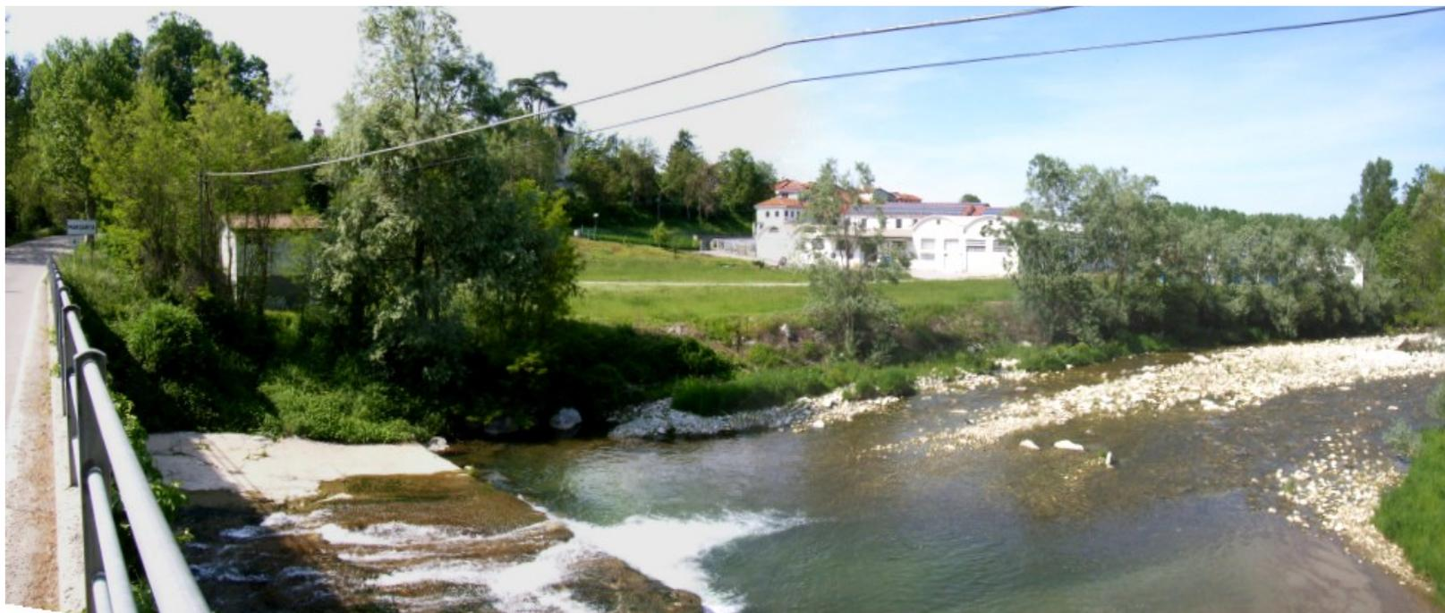
Foto 8: Vista generale dell'area dell'ex cartiera dalla spalletta del ponte sul T. Brobbio. In primo piano la soglia in c.a. La scogliera in sinistra orografica realizzata a seguito degli eventi del Nov. 1994 è in parte smantellata.
